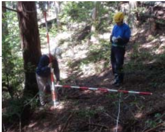
ポールで地山の傾斜を知る横断の測量
