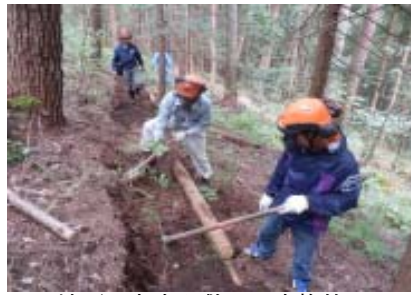
法面に丸太を敷いて本格的に
