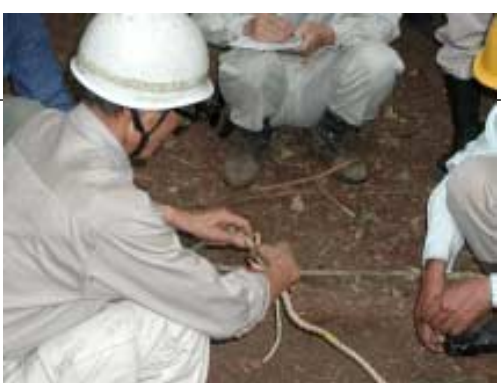
滑車を通すため、ショートブライスで輪をつくる
